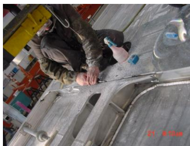
图 24—75 点固焊点处理示意图
