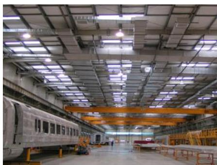
图 32-11 送风、回风管道安装实例
