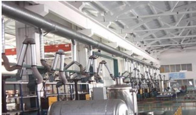
图 32-5 集中式焊烟净化器应用实例
