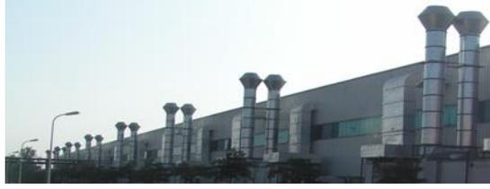
图 32-12 除尘除湿空调机组室外安装实例
