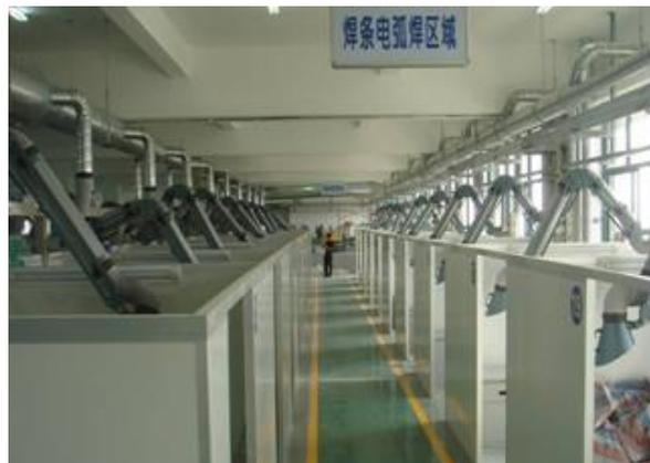
图 32-6 应用于焊接培训中心的集中式净化器实例
